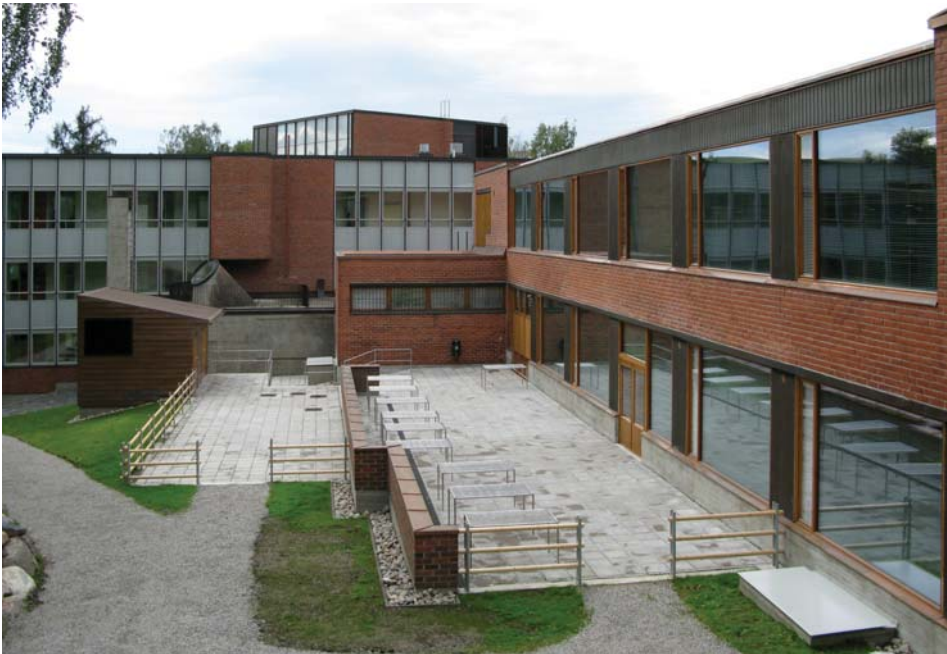
Ilokiven pihaterasseja: terassit uusittiin ja kaakkoisjulkisivun alkupe- räinen ikkunajako palautettiin (kuva 2016)
