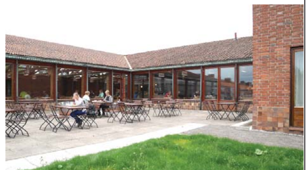
YLÄ: LYHTY JA LOZZIN KULMA ENNEN KUNNOSTUSTA VUONNA 2013. ALLA LOZZIN RUOKALAN TERRASSI KUNNOSTUKSEN JÄLKEEN VUONNA 2015.
