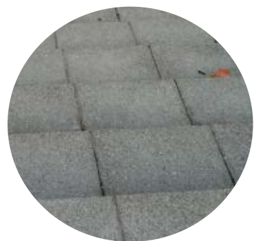
340x340x65 mm Kulttuurikeskuksen eteläpuoleisissa betonikiviportaissa
