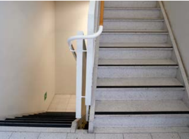
↑↑ Pohjakerroksen aulasta musiikkiopistokerrokseen ja ylös IV-konehuoneeseen saakka ulottuva pääporras on detaljoitu kuten lämpiön portaat: travertiinipintaiset suorareunaiset askelmat, lasikaide ja messinkinen käsijohde. amoy 2020
