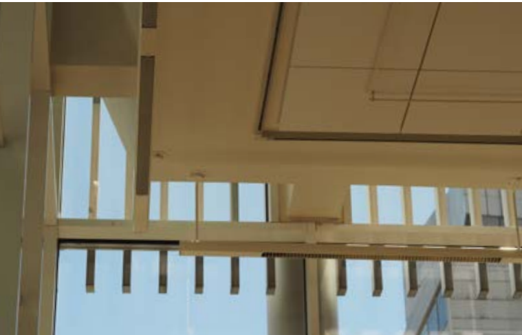
↑ Kevennetty lyhtyräystään kulma sisätilan puolelta kuvattuna. Pilari-palkki-liitokset on sijoitettu kulmien molemmiin puolin. amoy 2020
