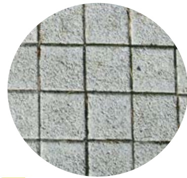
138x138x80 mm valkobetonikivi "Kartano" yleisön sisäänkäyntien yhteydessä ja itäjulkisivun ulkoportaassa, lisäksi asunnon kattoterassilla
